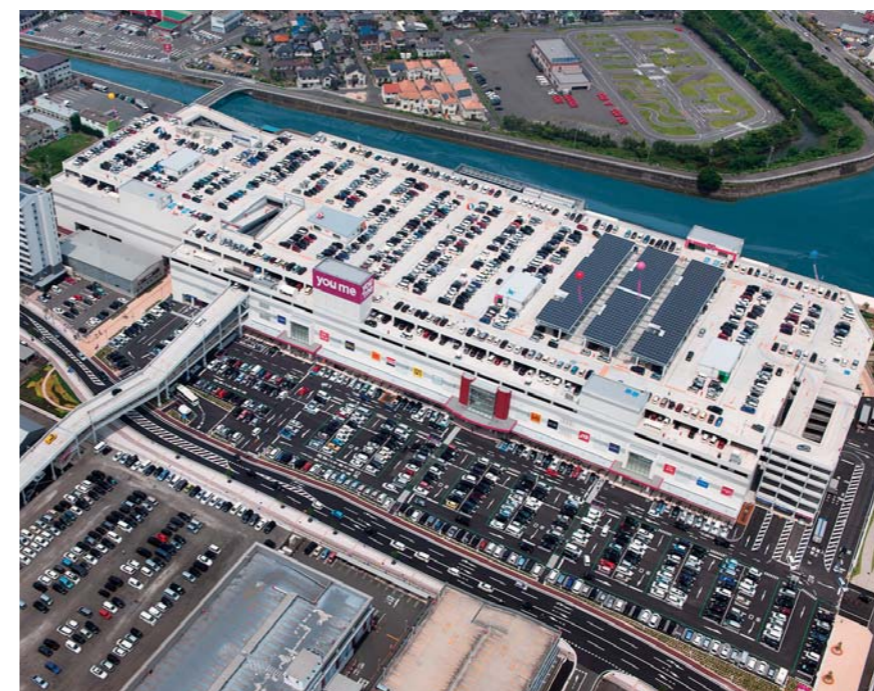
屋上に太陽光発電パネルを設置
