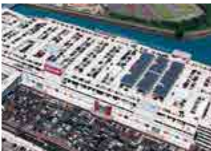
ゆめタウン廿日市の屋上駐車場の一角に発電パネルを設置
