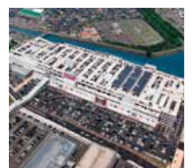
「ゆめタウン廿日市」の屋上に設置した太陽光発電パネル
