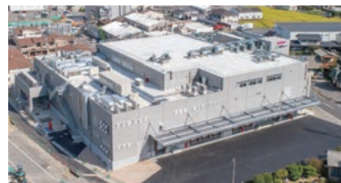
深川第二工場
