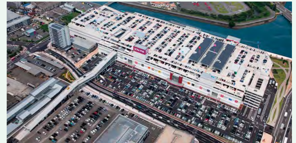
屋上に発電パネルを設置
