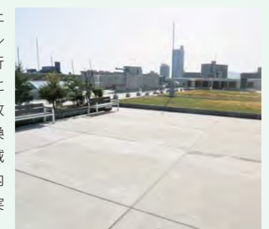
緑化を行った本社ビル屋上
