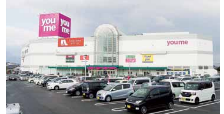
2016年12月に開業したゆめタウン南行橋
